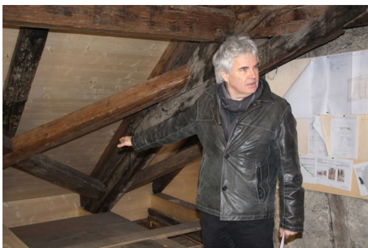
1/3 Bild: Katja Fässler Denkmalpfleger Ruedi Elser verweist auf besonders komplexe Balkenrekonstruktionen auf dem Dachstock.
